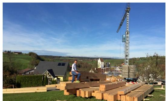
Untergeschossdecke montiert. Darauf werden die 35 cm dicken Balken montiert. Die Verbindungen der einzelnen Balkenlagen sind mit Nut und Holzfeder in der Längsrichtung gehalten, mit Schafswolle und „Gummi“ winddicht gemacht und mit Holzdübeln vertikal verbunden.
