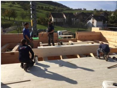
Terminlich ineinandergreifend montiert der Zimmermann die **Dachgeschossbodenplatten** (auch der Bauherr hilft tatkräftig mit) und erstellt die Giebelwandkonstruktion im gewohnten Holzbaustil, eine konstruktive Massnahme um ungleichmässige Setzungen im Giebel- und Dachbereich zu vermeiden.
