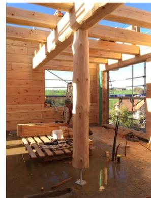
Im offenen Wohn-Ess-Kochbereich braucht der Deckenbalkenträger einen Pfosten für die Statik. Dieser steht auf einem höhenverstellbaren Pfostenfuss um mit der Holzsetzung mitzugehen. In den folgenden 2-3 Jahren werden das 5% der anfänglichen Höhe sein, was im Erdgeschoss doch beachtliche 15 cm, um welches das Haus an Höhe verliert.
