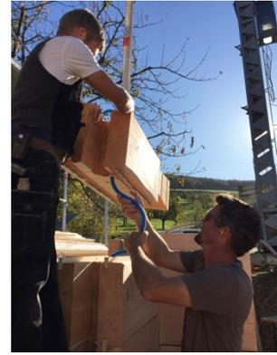
Für die Rohinstallationsrohre werden vorgängig nach unseren Plänen Lochungen gebohrt um diese während dem Aufbau an Ort zu ziehen.
