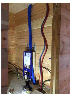
Der Rohbau musste im Oltinger Herbst so manchem Sturm standhalten. Aber die **Rohinstallationen** schreiten zügig voran, auch dank der passenden Vorlochung in den Balken für die Schutzrohre der Installateure. Die vorgängige Zusammenarbeit zwischen Elektriker und Blockbauer zeigt sich als sehr hilfreich und passend.
